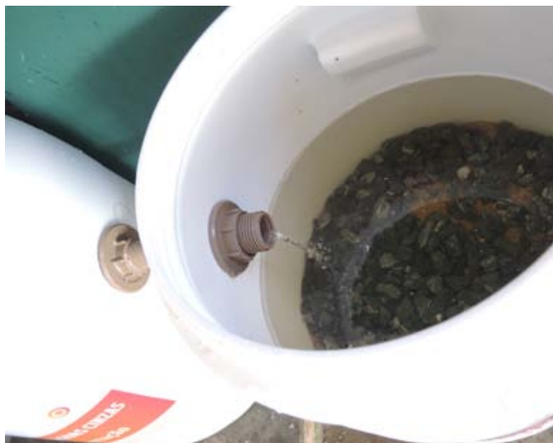
Filtros de Águas Cinzas instalados. Ao lado, o processo de filtragem
