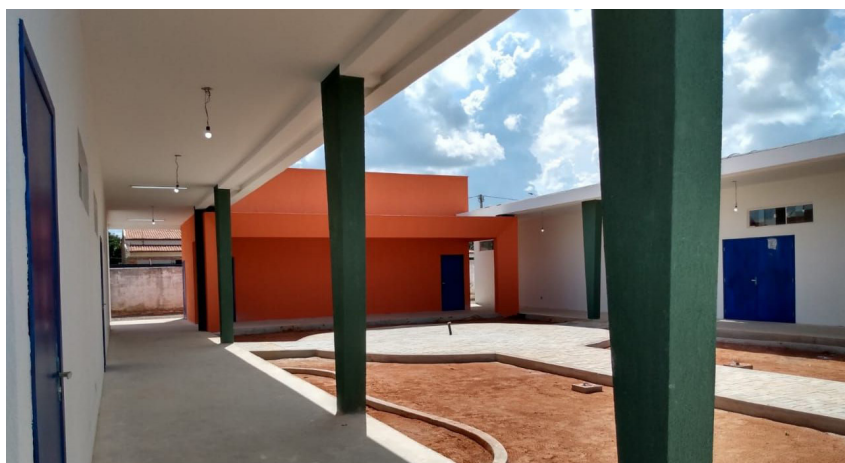
Detalhe do novo Auditório Ventos que Transformam, na escola Padre José de Anchieta em Serra do Mel, RN
