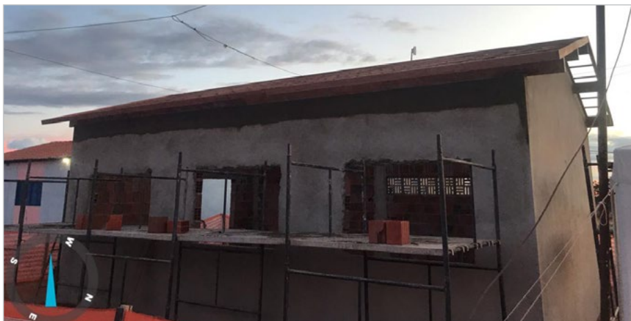
Obra em Serra do Mel (RN) avançando
