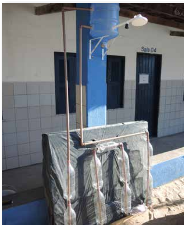
Aquecedor solar de água em Caucaia
