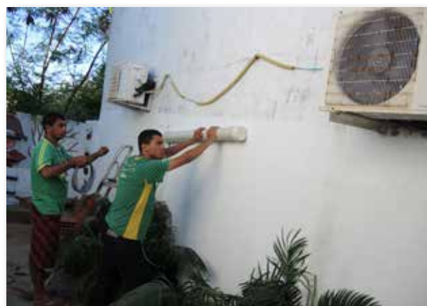
Reaproveitamento das águas do ar condicionado, em Caucaia
