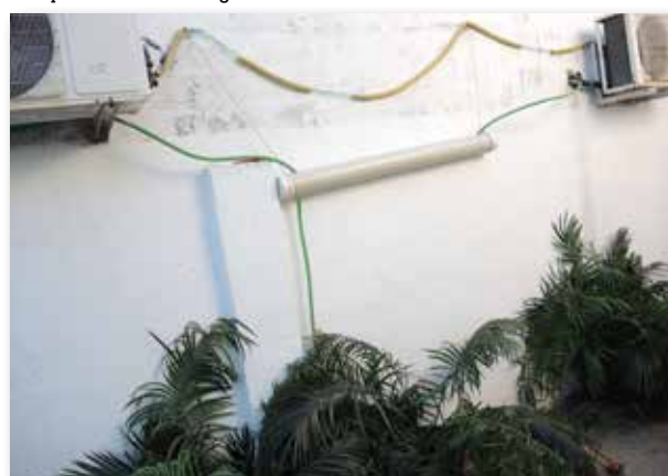
Reaproveitamento das águas do ar condicionado, em Caucaia
