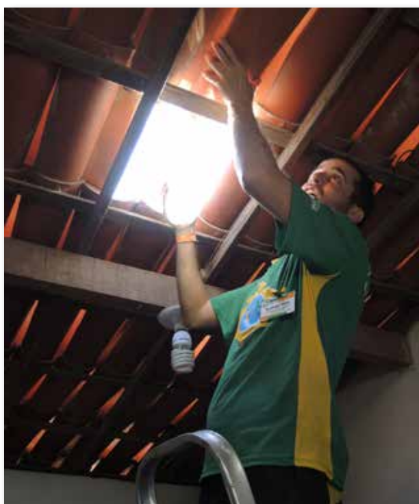
Educador do IBS durante instalação (Caucaia)
