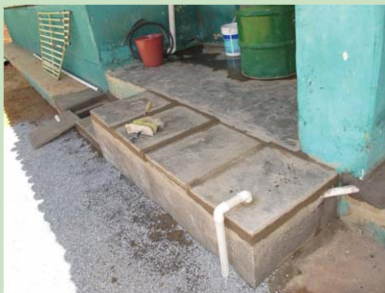
A água "com flocos" passa pelo decantador ou flotador objetivando a eliminação dos flocos, por decantação ou flotação.
