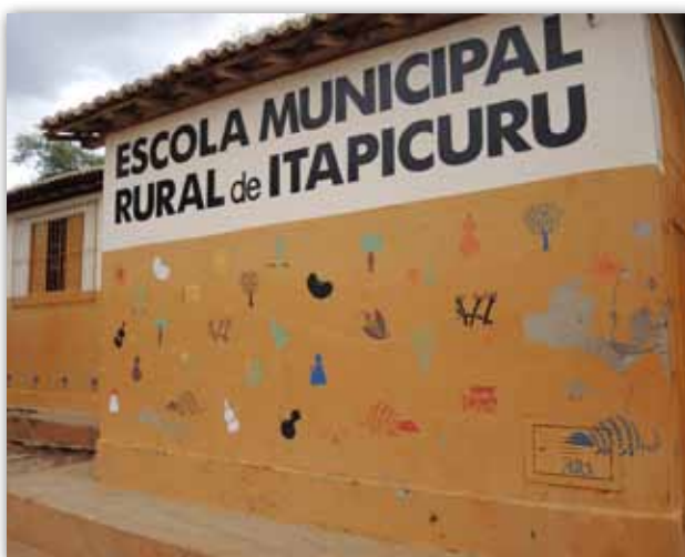
Fachada da escola renovada: alegria da criançada
