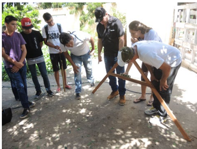
Demarcação com as curvas de níveis para as valas de infiltração ajuda a evitar a erosão do solo
